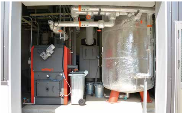
ふじやまビル様に施工したバイオマスチップポイラー
